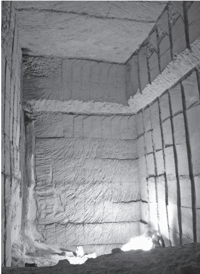
AFBEELDING 13 : Een gang ontgonnen met een ontginningsmethode uit de groep 'zaag en slagbeitel'. (Foto Kevin Amendt. Oude Maarendalgroeve.)
