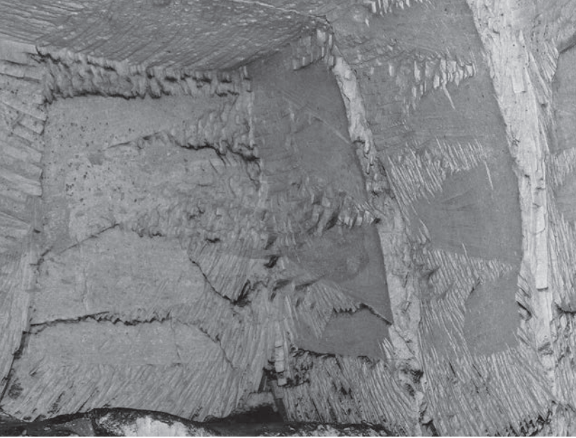
AFBEELDING 7: Een werkfront waar is gewerkt met een ontginningsmethode uit de groep 'slagbeitel'. Het blok in de hoek is uitgewerkt met aan beide zijden het gebruik van een voor met herhaald driehoekpatroon. (Foto Peter Jennekens. Groeve Temaaïen Midden.)
