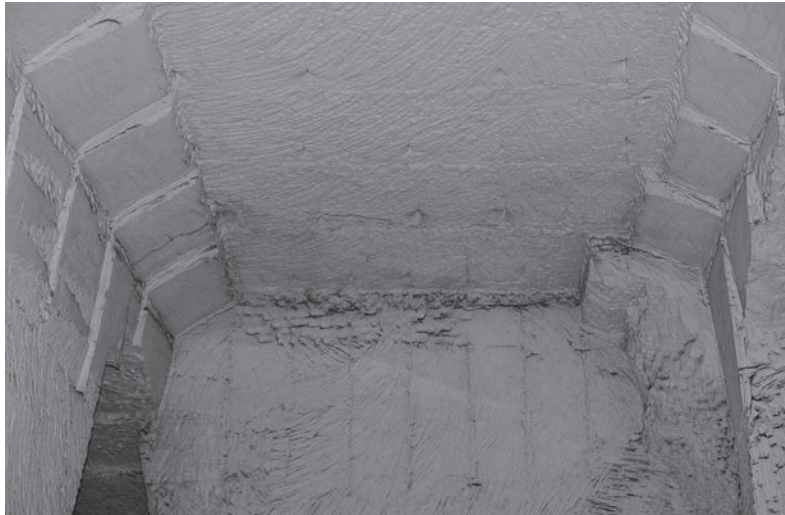
AFBEELDING 15: Een van de eerste werkfronten in de Caestertgroeve met een ontginningsmethode uit de groep 'zaag en slagbeitel'. Ook hier is de verkanting, in de hoek tussen wand en plafond, duidelijk zichtbaar. (Foto Peter Jennekens. Caestertgroeve.)
